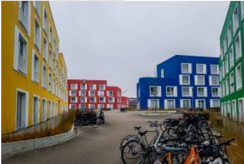
Das Wohnheim des Studierendenwerkes an der Boeselagerstraße in Münster. (Foto: privat)
